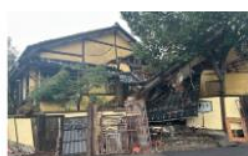
倒壊した建物
