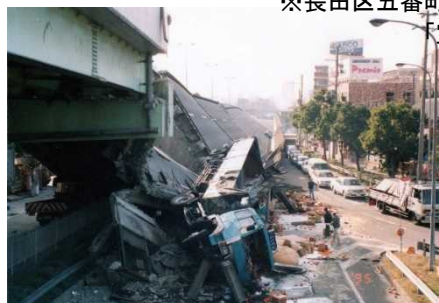
※灘区国道 43 号線岩屋交差点周辺
